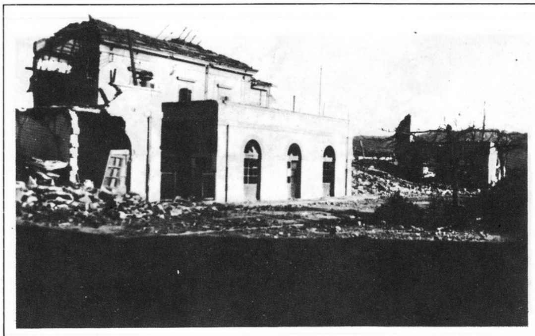
Il fabbricato viaggiatori visto dal piazzale esterno
