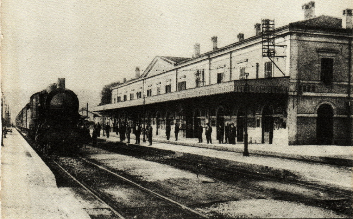
Orte - Stazione Ferroviaria
