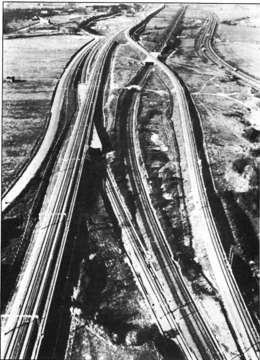
Seconda interconnessione «Orte Nord» poco dopo lo sbocco nord della galleria di Orte (91)
