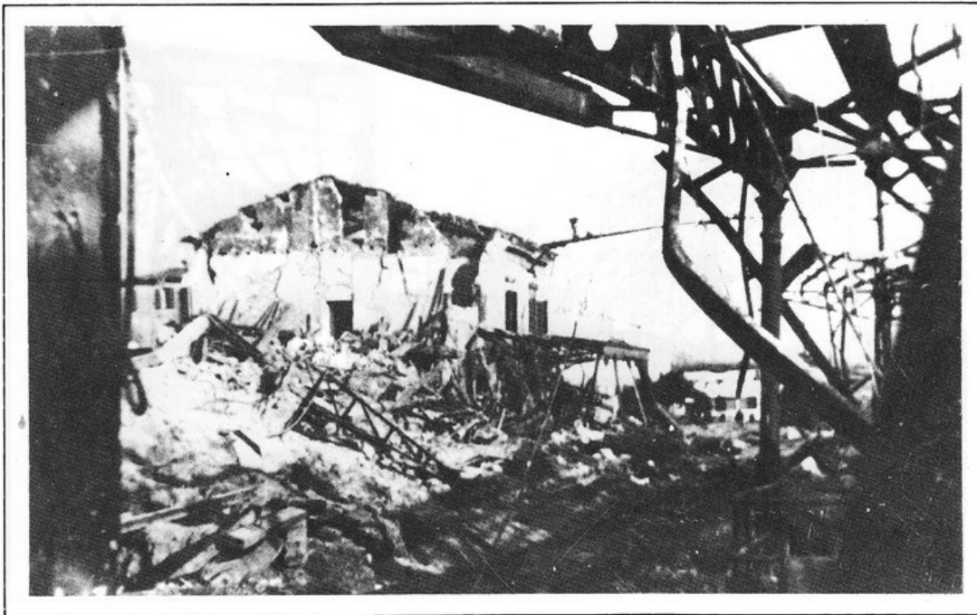
Il fabbricato viaggiatori visto dall'interno
